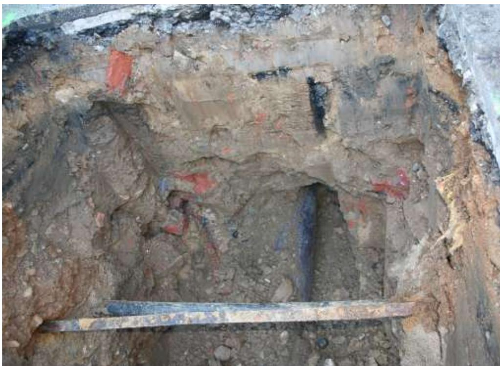
**Abb. 22:** Stelle 28, Versorgungsleitungen direkt vor Haus Nr. 30, Willmuthstraße, schwarz die aus dem Haus herausführende Abwasserleitung, darüber Bauschutt des Vorgängerhauses
