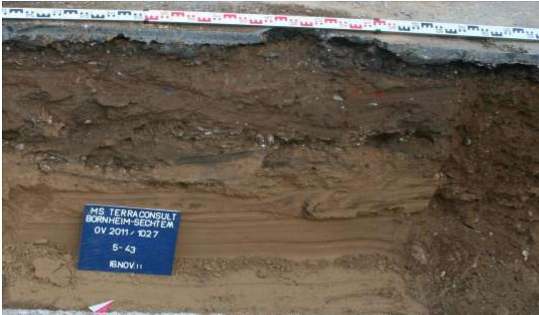
**Abb. 14:** Profilausschnitt mit auf Löss aufliegendem Straßenkörper und eingelagertem Ziegelbruch, rechts ein tieferreichender durch eine quer verlaufende Leitung bedingter moderner Bodeneingriff (Foto E. Biermann)
