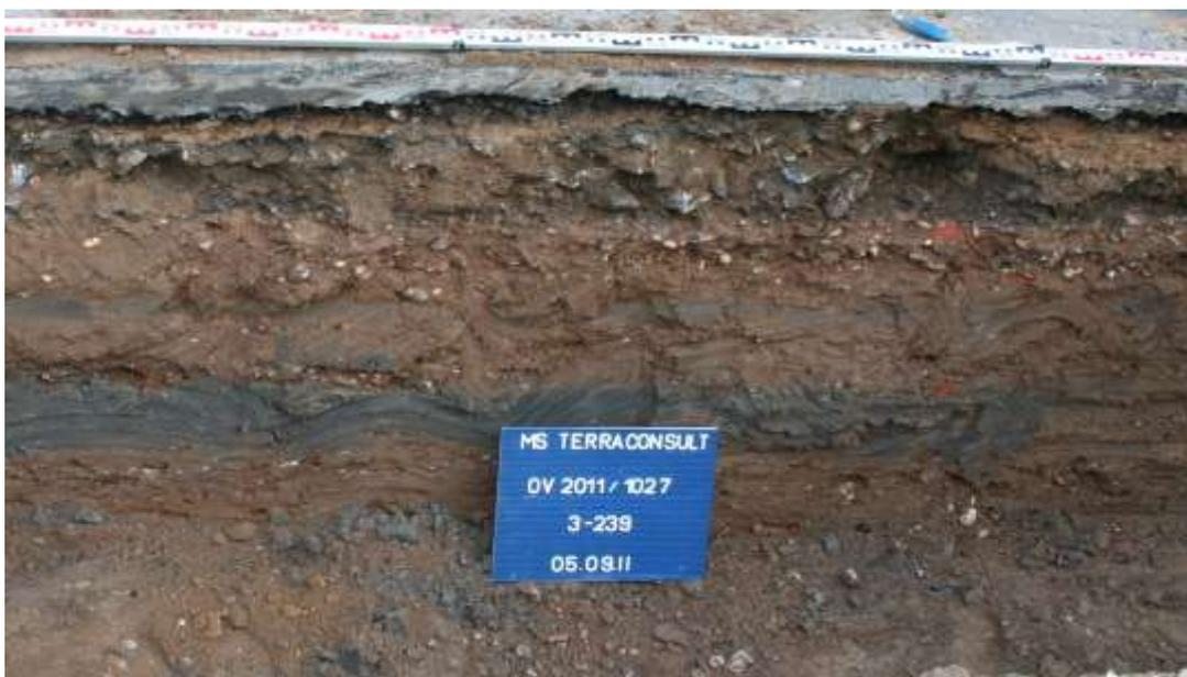
**Abb. 15:** Planierschichten des Straßenkörpers mit grauer, toniger Schicht, z.T. mit Asphalt- und Ziegelstückchen (Foto: E. Biermann)
