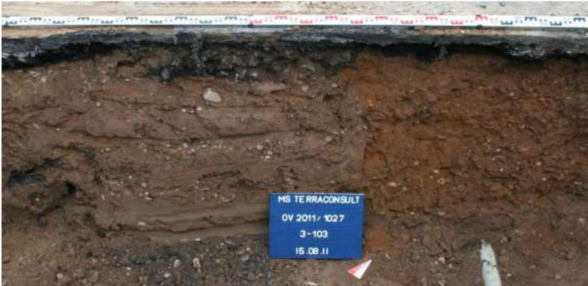
**Abb. 18:** Straßenunterbau (links) und Verfüllung eines überlagernden Leitungsgrabens (rechts)
